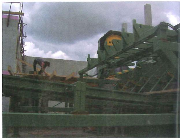
Installation d'un process de sciage gros bois au cœur d'une scierie allemande possédant deux lignes de canter débitant 500 000 m<sup>3</sup> de grumes par an.
